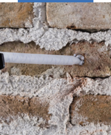
Applicazione di fissaggio chimico
