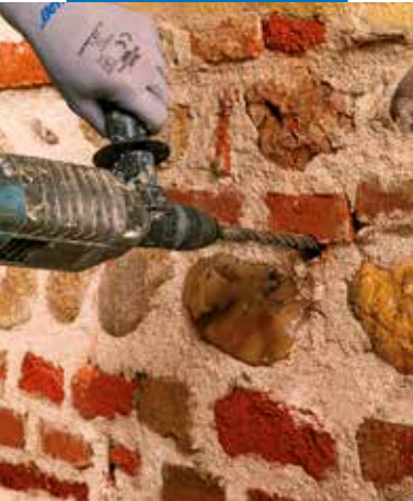
Realizzazione dei fori per Mapenet EM Connector
