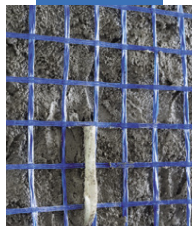
Posa di MapeNet EM
