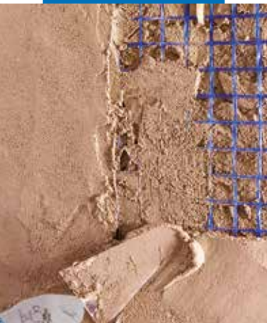
Applicazione del secondo strato di MapeWall Intonaca & Rinforza
