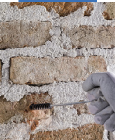
Asportazione delle polveri dai fori
